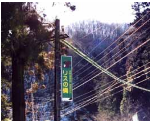
写真 - 4 リス専用の橋 6)
