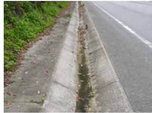
写真 - 1 1 勾配のある側溝
