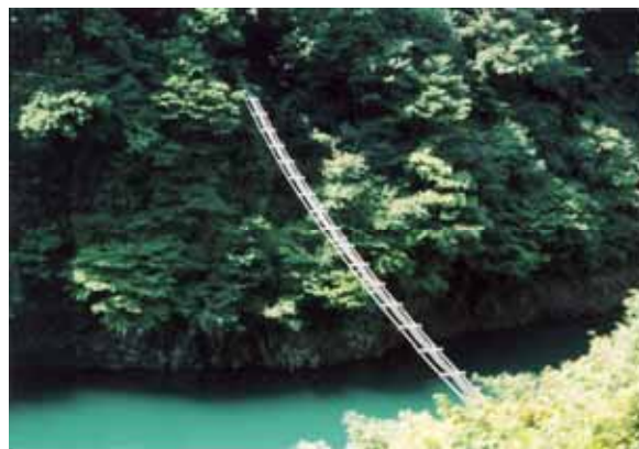
写真 - 5 サル専用の橋（吊橋）
